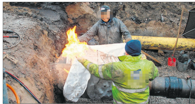
Die Arbeiter wollen sie daher mit einer Decke ersticken.
