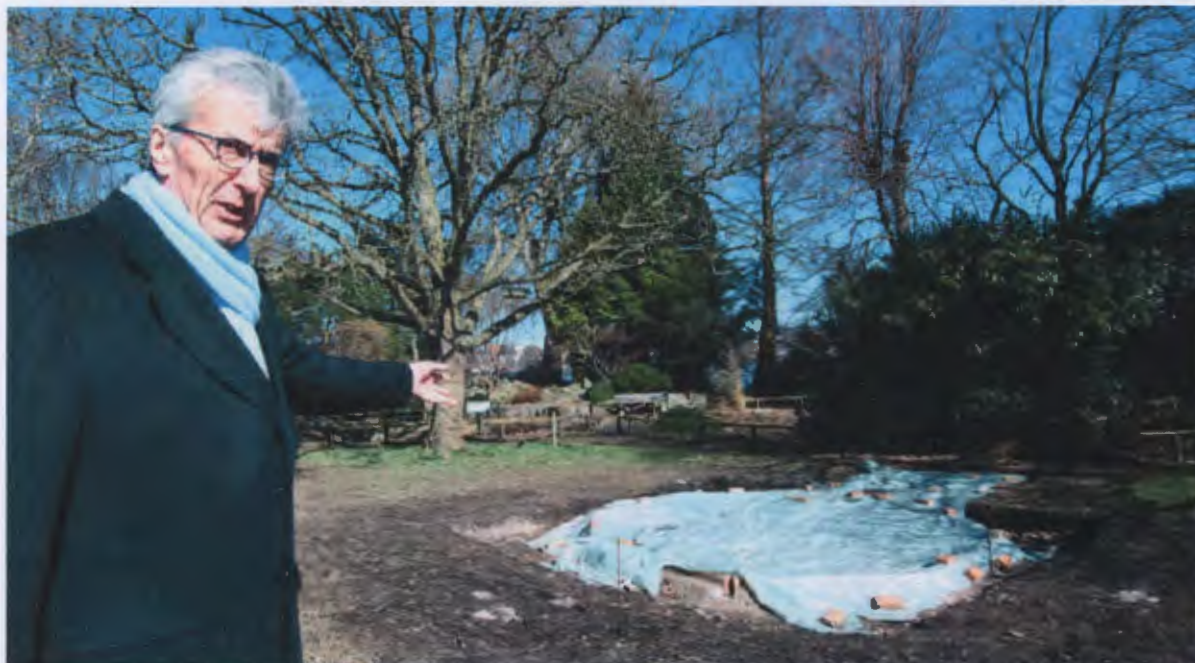
Michael Haukohl zeigt das Fundament des neuen Bücherpavillons.
